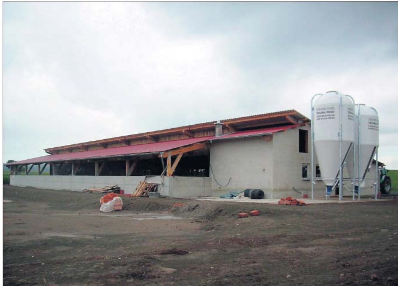
Einzigartige Bauweise in Oberfranken: Der neue Klima-Schweinestall der Familie Schreiner zwischen Wiesefeld und Herbartsdorf.
